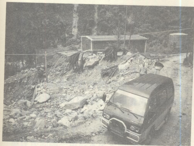
◎上圖：此處為潭南往地利中途，原道路在中央，土石沖積達10公尺淹沒房屋，目前鋪設涵管便道。
